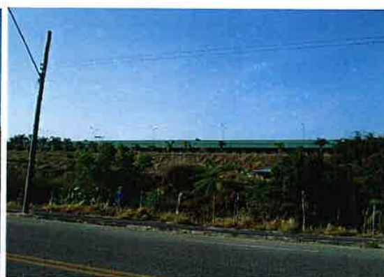
VISTA EXTERNA DO IMÓVEL
