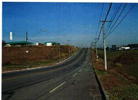
AV. PEDRO I COM IMÓVEL A ESQUERDA
