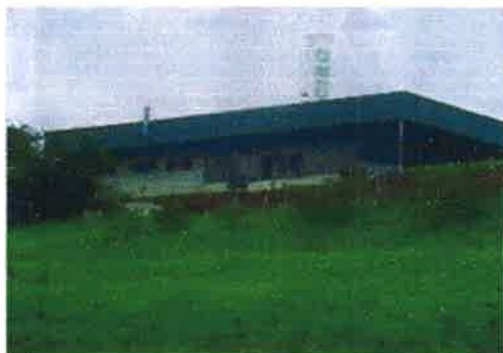
VISTA DO ATERRO DESCOLADO
