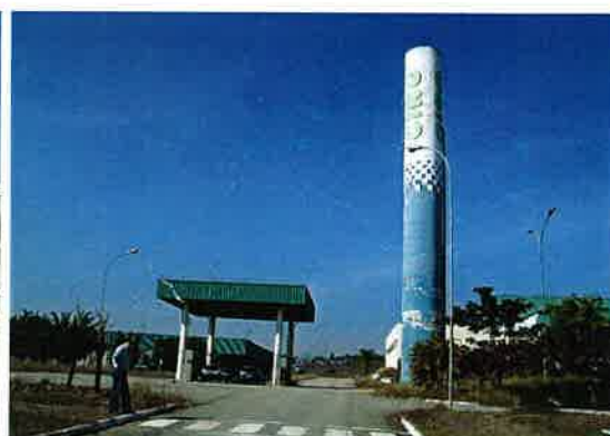
COBERTURA POSTO DIESEL
